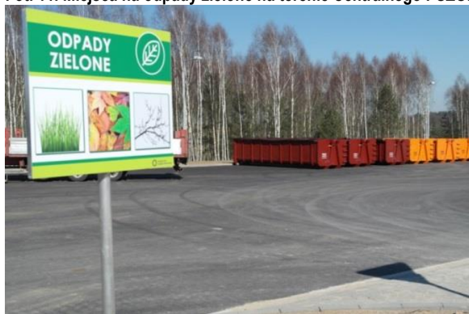
Fot. 11. Miejsca na odpady zielone na terenie Centralnego PSZOK
