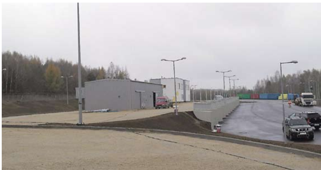
Widok od strony wjazdu na rampę.
