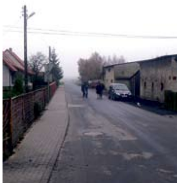
Prace na drodze do Przesiecznej zakończyły drugi etap tej inwestycji.
