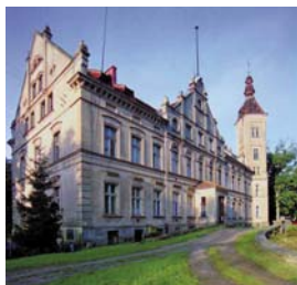
Pałac w Nowym Dworze
