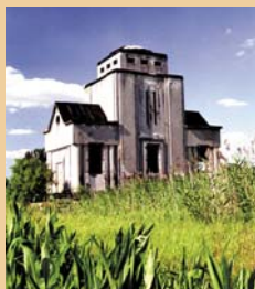
Przepompownia w Leszkowicach
