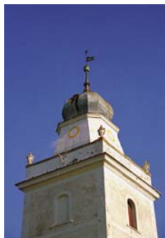
Wieża kościoła w Sobinie
